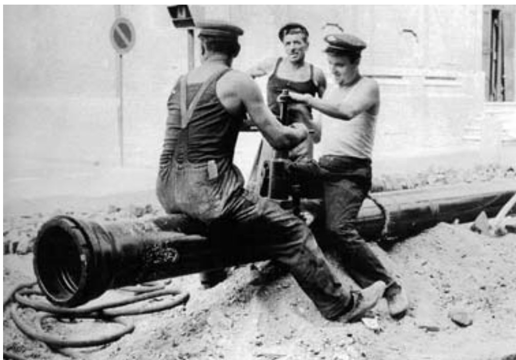
Operai al lavoro nella posa delle tubazioni del gas, anni Cinquanta. (da Gli uomini e le opere. L'edilizia modenese nella fotografia , a cura di P. Battaglia, A. Manicardi e C. Reverberi, Associazione Costruttori Edili e Complementari della Provincia di Modena, Modena, 2007)
