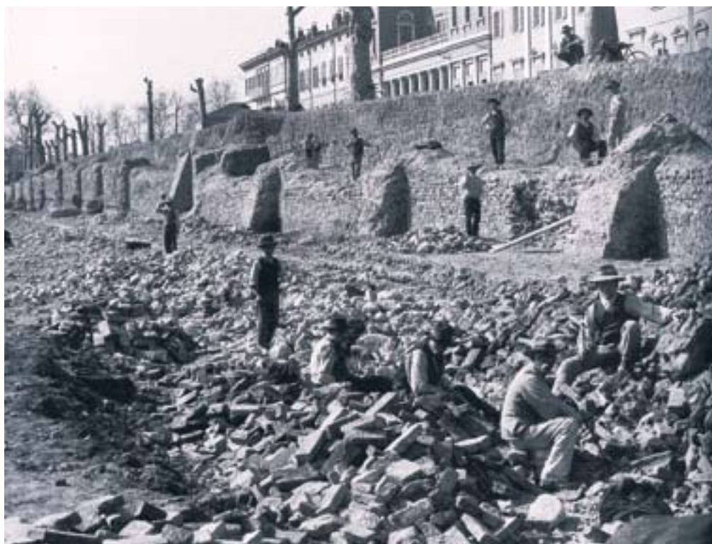
I lavori di abbattimento delle Mura, nel tratto dalla Barriera Garibaldi al Baluardo San Pietro, 1911-13. (foto U. Orlandini, Fotomuseo Giuseppe Panini, Modena)
