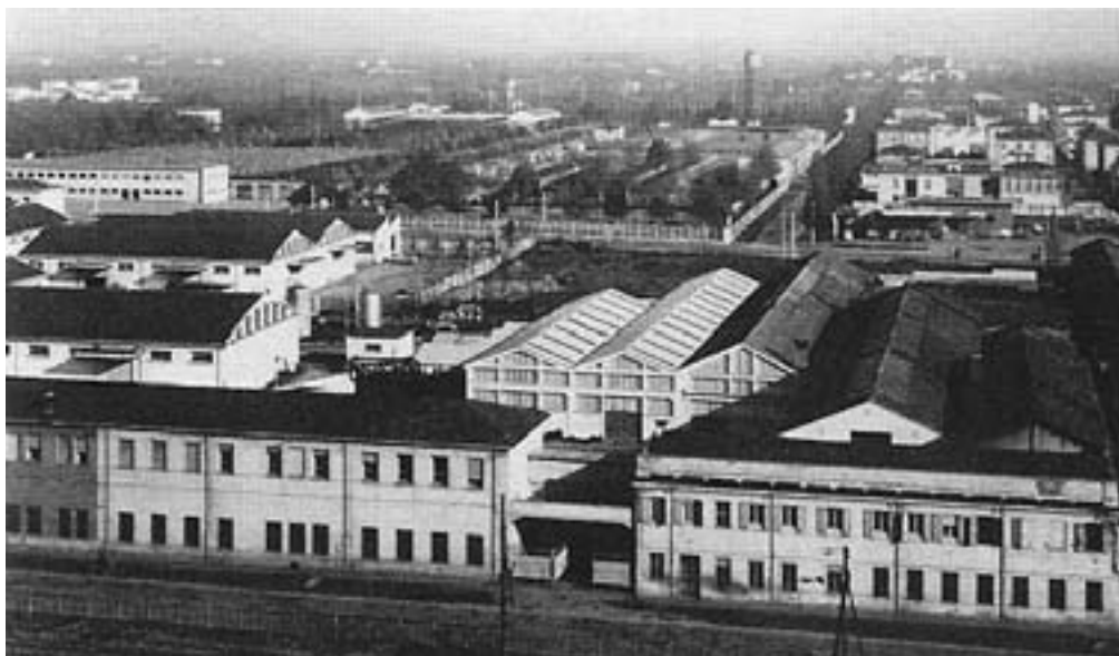
Officine Rizzi, vista esterna della più antica industria metalmeccanica modenese. Tutta l'area è stata demolita tra il 2000 e il 2001. (Archivio Officine Rizzi)
