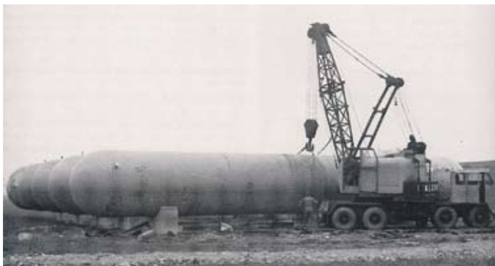
Veduta dei serbatoi per lo stoccaggio del metano in via Morane. (Archivio Hera Modena: fascicolo per il Cinquantesimo AMCM)
